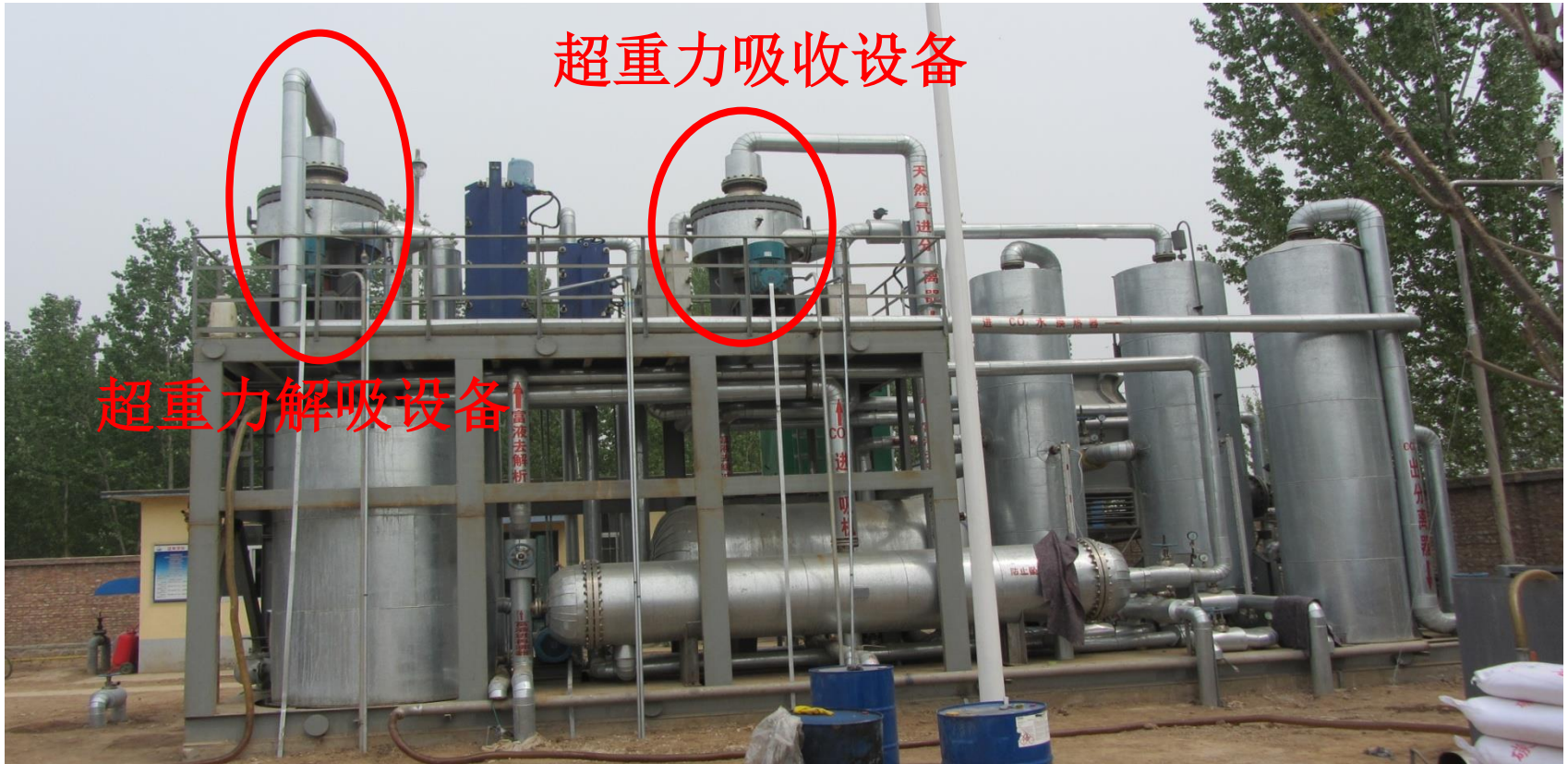
采出气处理能力为30000Nm 3 /d 超重力二氧化碳捕集纯化工业示范线
