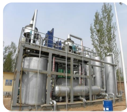
化学吸收脱碳系统
